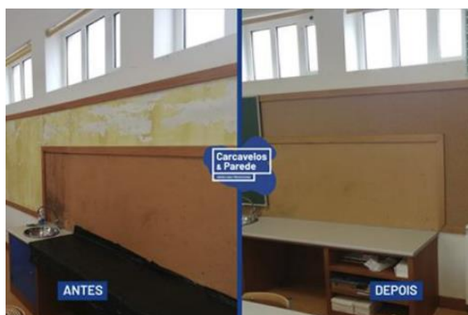
SUBSTITUIÇÃO DOS PAINÉIS EM CORTIÇA DAS ESCOLAS DO 1.º Ciclo.
