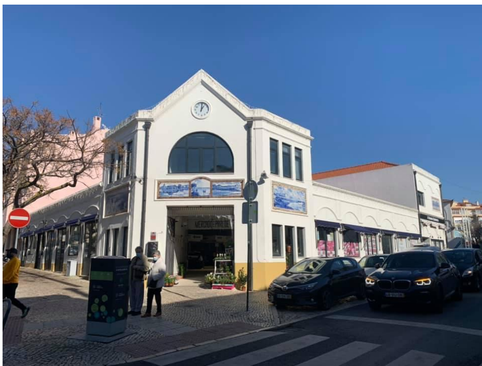
Restauro dos Painéis do Mercado de Parede
