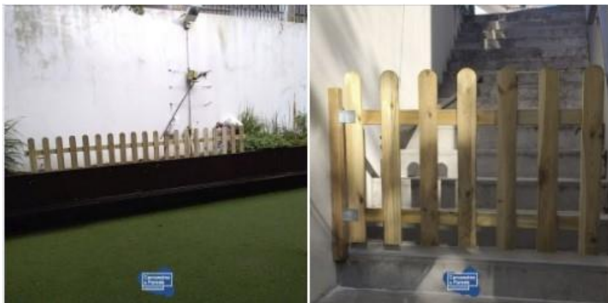
Jardim de Infância Conde Ferreira - Colocação de cerca
